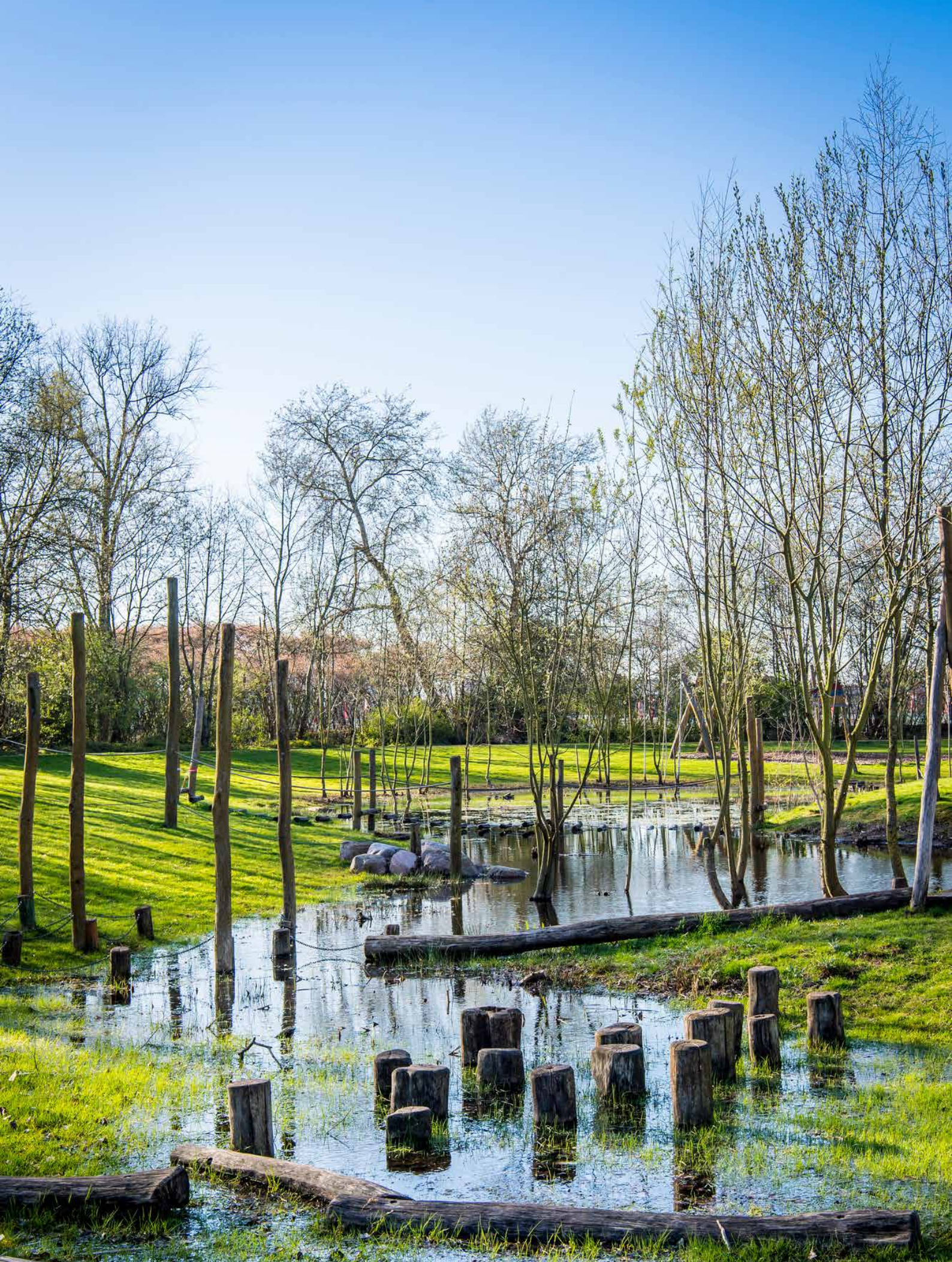
De wadi's op Bremweide laten het regenwater traag in de ondergrond infiltreren en zijn ook een avontuurlijke speeltuin
