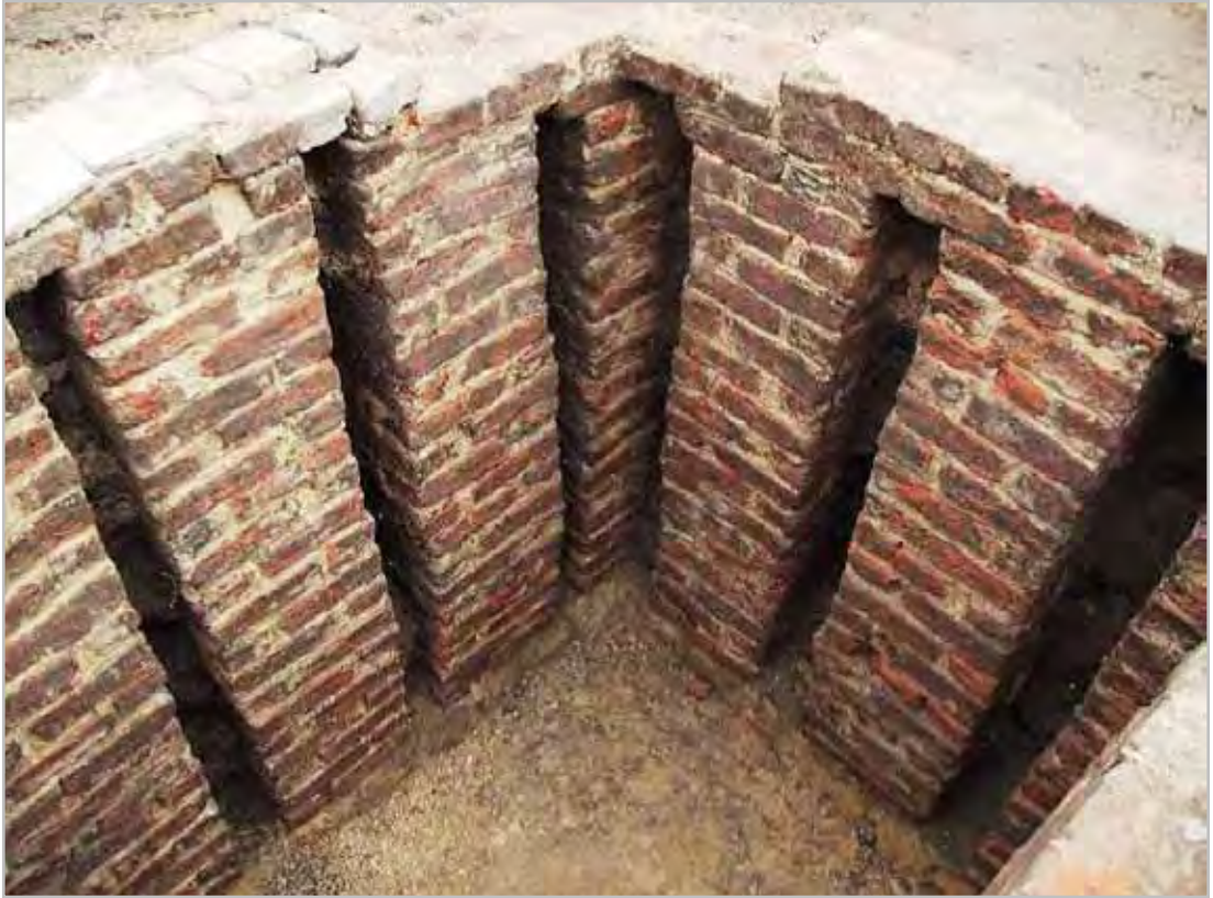
Figuur 20. Detailopname van de drainagesleuven in put S30/31
